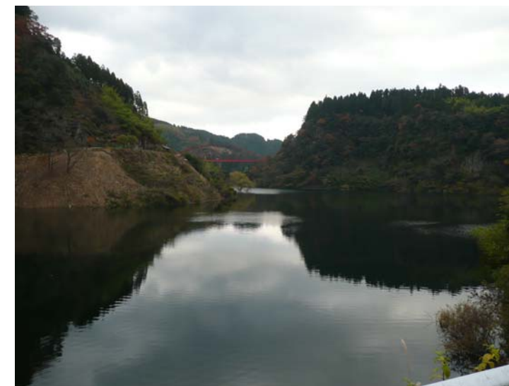
『津江取水口付近より下流を望む』
