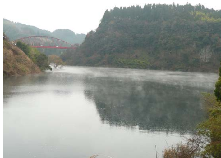
『津江導水取水口付近より下流を望む』
