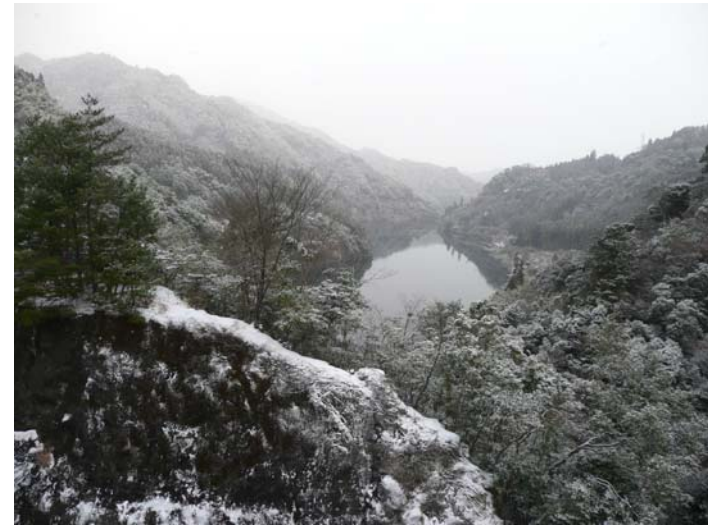
『管理支所から下流（松原ダム湖）を望む』
