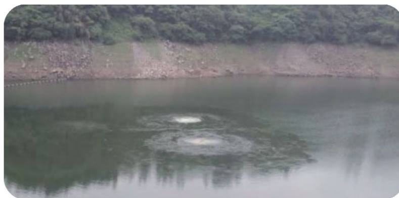
松原ダムの曝気の様子
