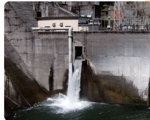
松原ダム下流放水口
