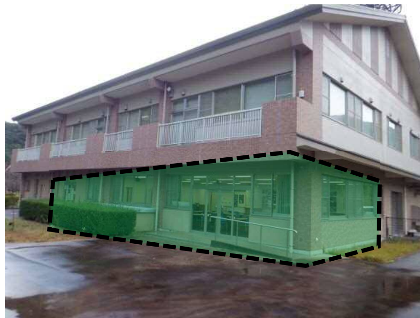
管理所外観 (枠内:利用可能エリア)
