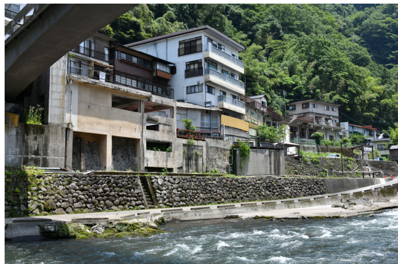
発生材を用いることで現地の石積み護岸との調和を図る(杖立温泉)
