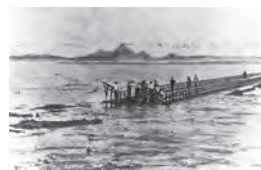
筑後川にかかる橋が流されました。(久留米市)
