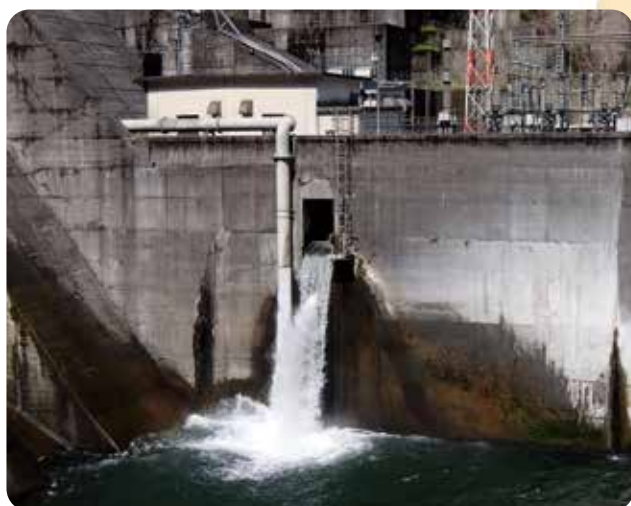
松原ダム下流放水口
