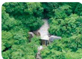
③小竹川貯砂ダム
