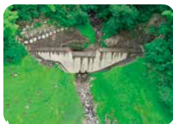
⑤わらべの谷貯砂ダム
