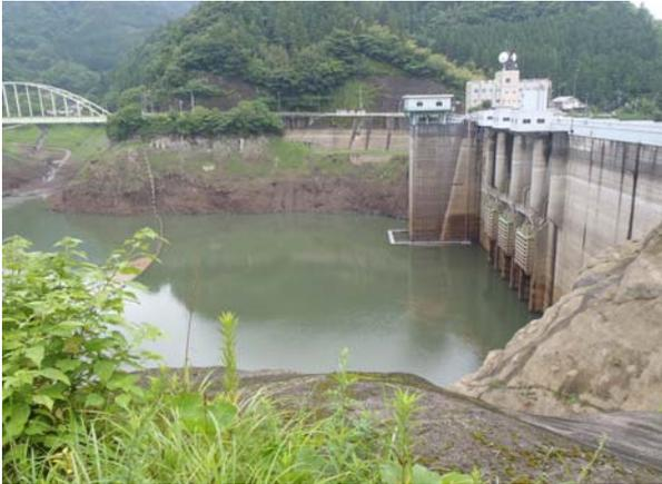
(松原ダム 洪水調節中の貯水位)
