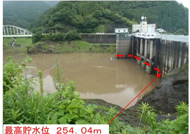
(下笠ダム 洪水調節前の貯水位)
