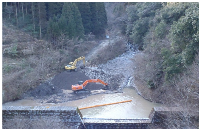
堆積土砂撤去の状況(蕨野谷貯砂ダム)
