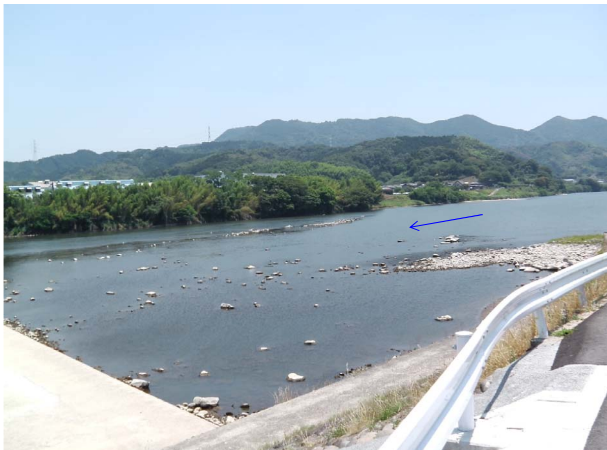
大石堰上流:6月15日時点(放流前)
