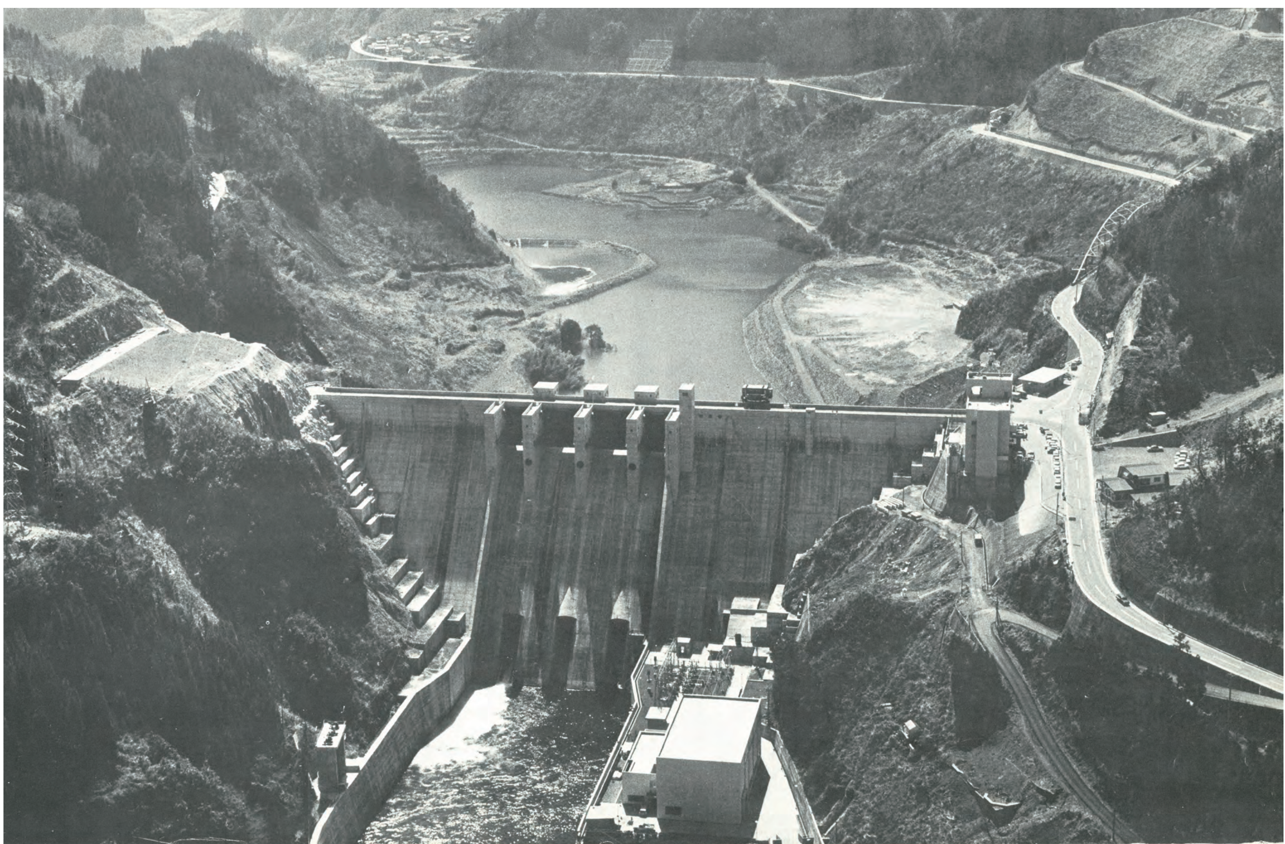
完成当時の松原ダム
