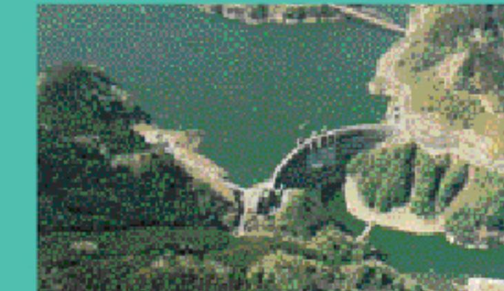
ダムの上流側に丸みをもたせたコンクリートダムをアーチ式ダムといいます。これはダムの丸みによって水の力を両岸に伝えるため、重力式ダムのようにダム自体を重く厚くつくるなくてすみます。しかし水の力を支える両岸がかたい岩で出来ているところでないとつくれません。
