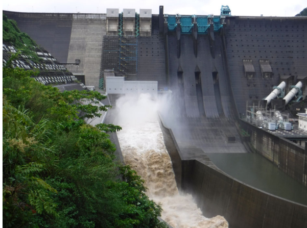
ゲート放流状況(8月10日6:00頃)
