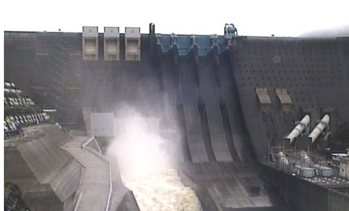
ゲート放流状況(15日18時40分頃)
