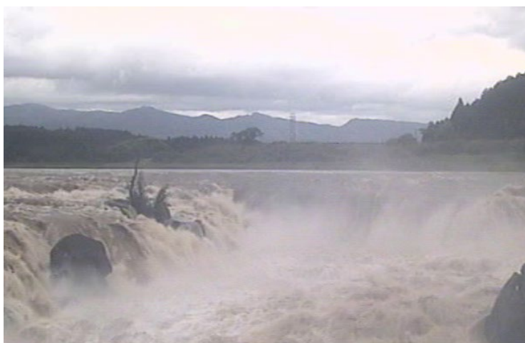
ダム上流「曾木の滝」の状況 (27日15時00分頃)
