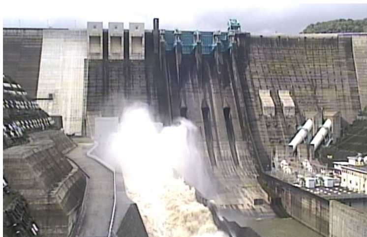
ゲート放流状況 (27日15時10分頃)
