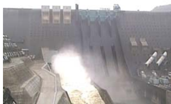
洪水調節中のゲート放流状況
