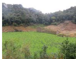
R1年11月曾木発電所遺構付近
