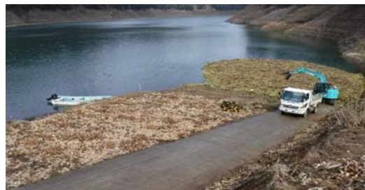
＜重機による水草回収の状況＞
