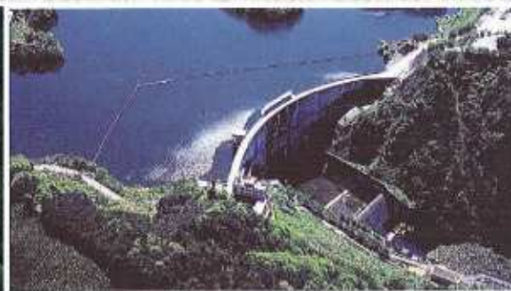
清蓮寺ダム(水資源機構)
