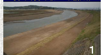
菱刈町菱刈地区:河道掘削
