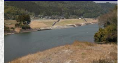
さつま町二渡地区:築堤
