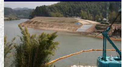
薩摩川内市久住地先:築堤
