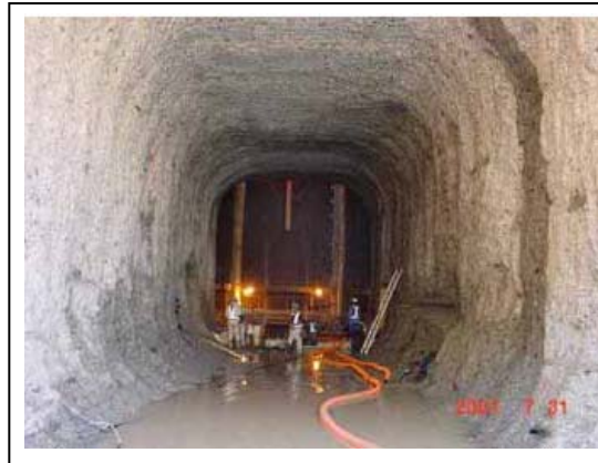
堤体貫通状況(他ダム事例)
