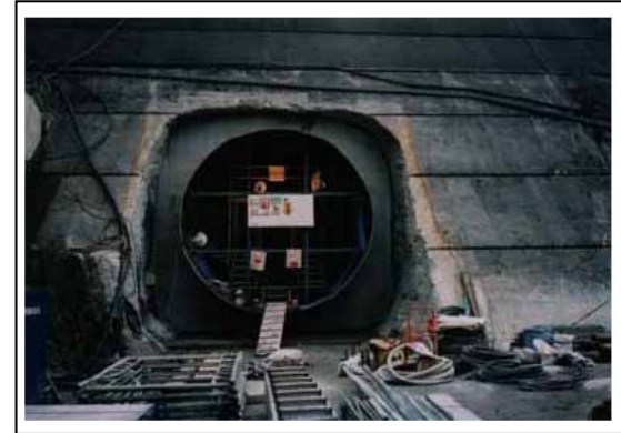
放流管組立状況(他ダム事例)
