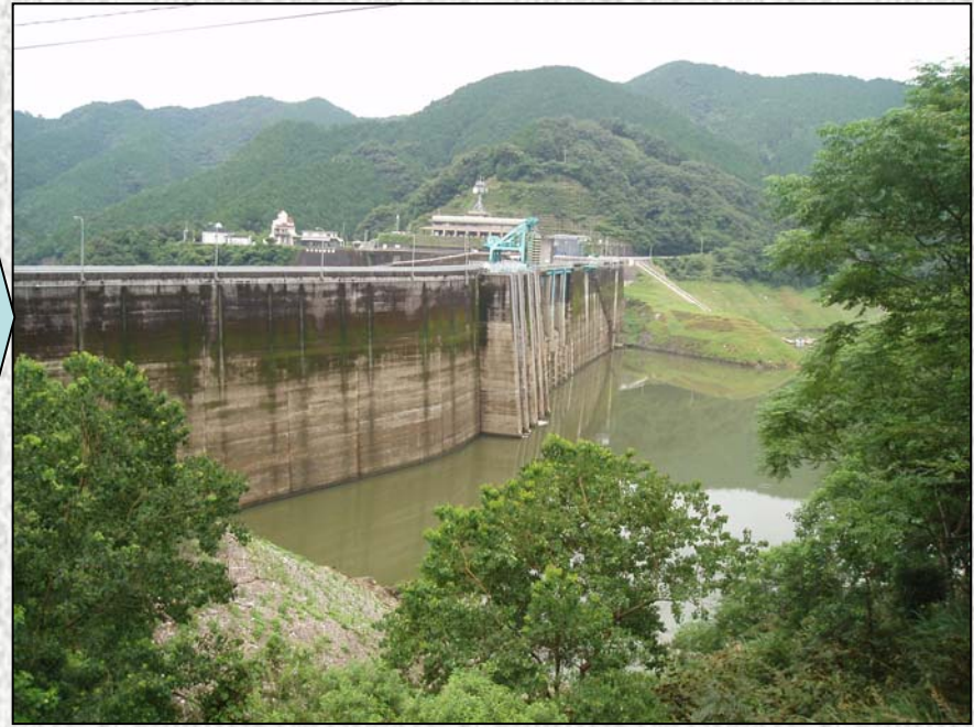
洪水を貯留した後 洪水貯留量約14万m 3
