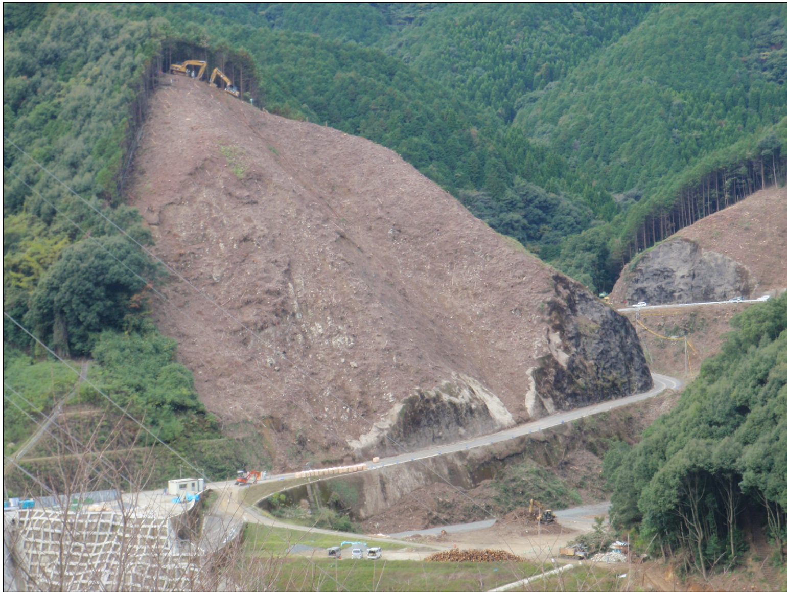
鶴田ダム下流右岸側工事用道路
