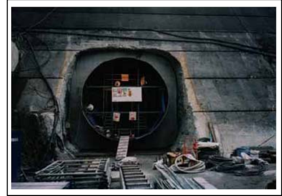
放流管組立状況(他ダム事例)
