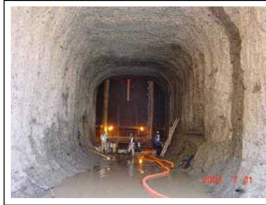
堤体貫通状況(他ダム事例)
