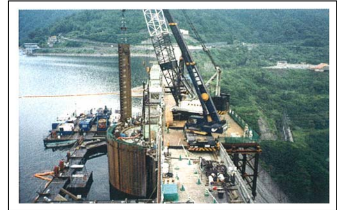
上流仮締切設置状況(他ダム事例)
