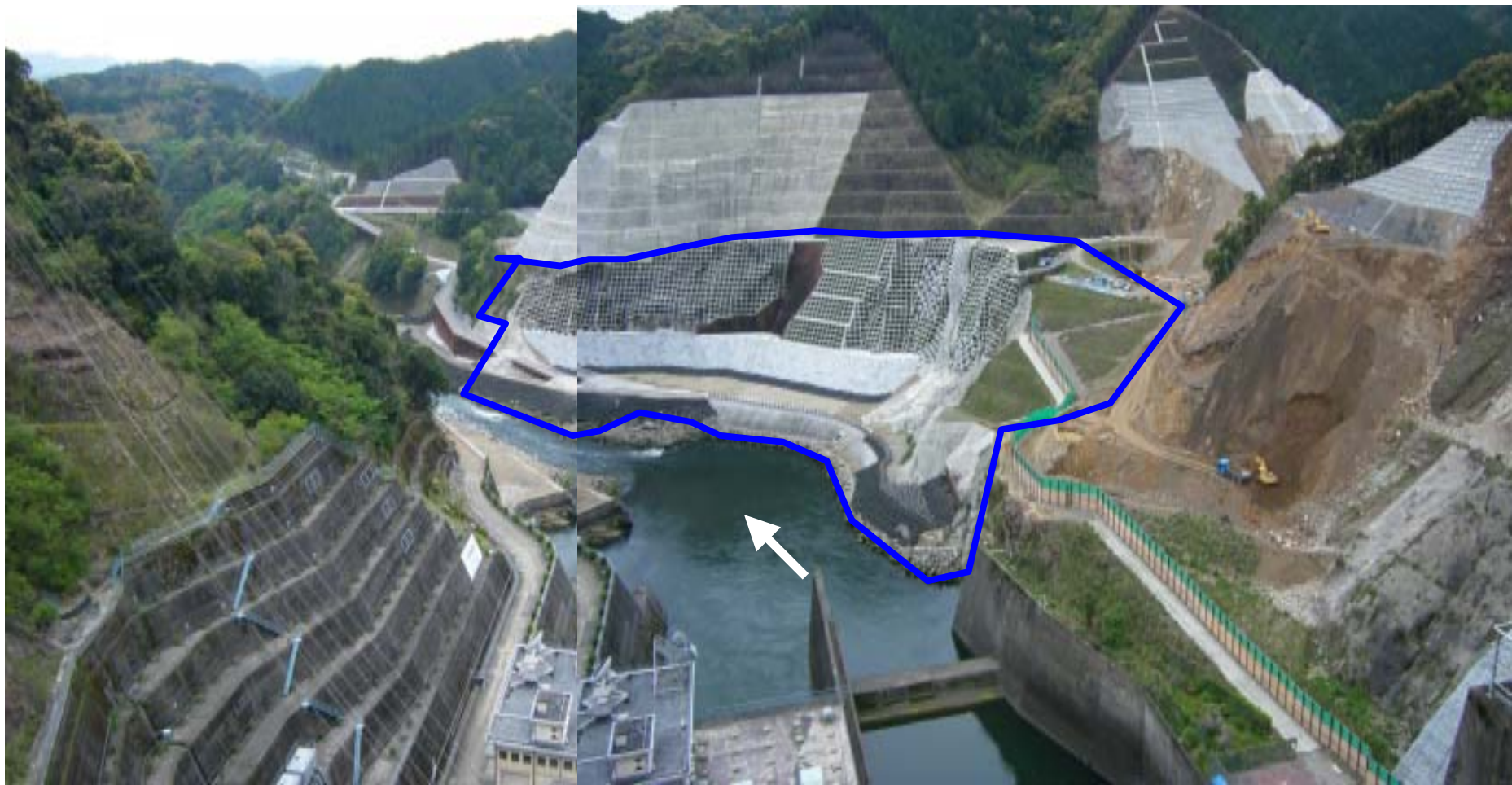
ダム天端から下流側（右岸）を望む
