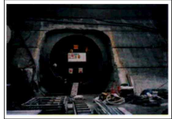
放流管組立状況(他ダム事例)
