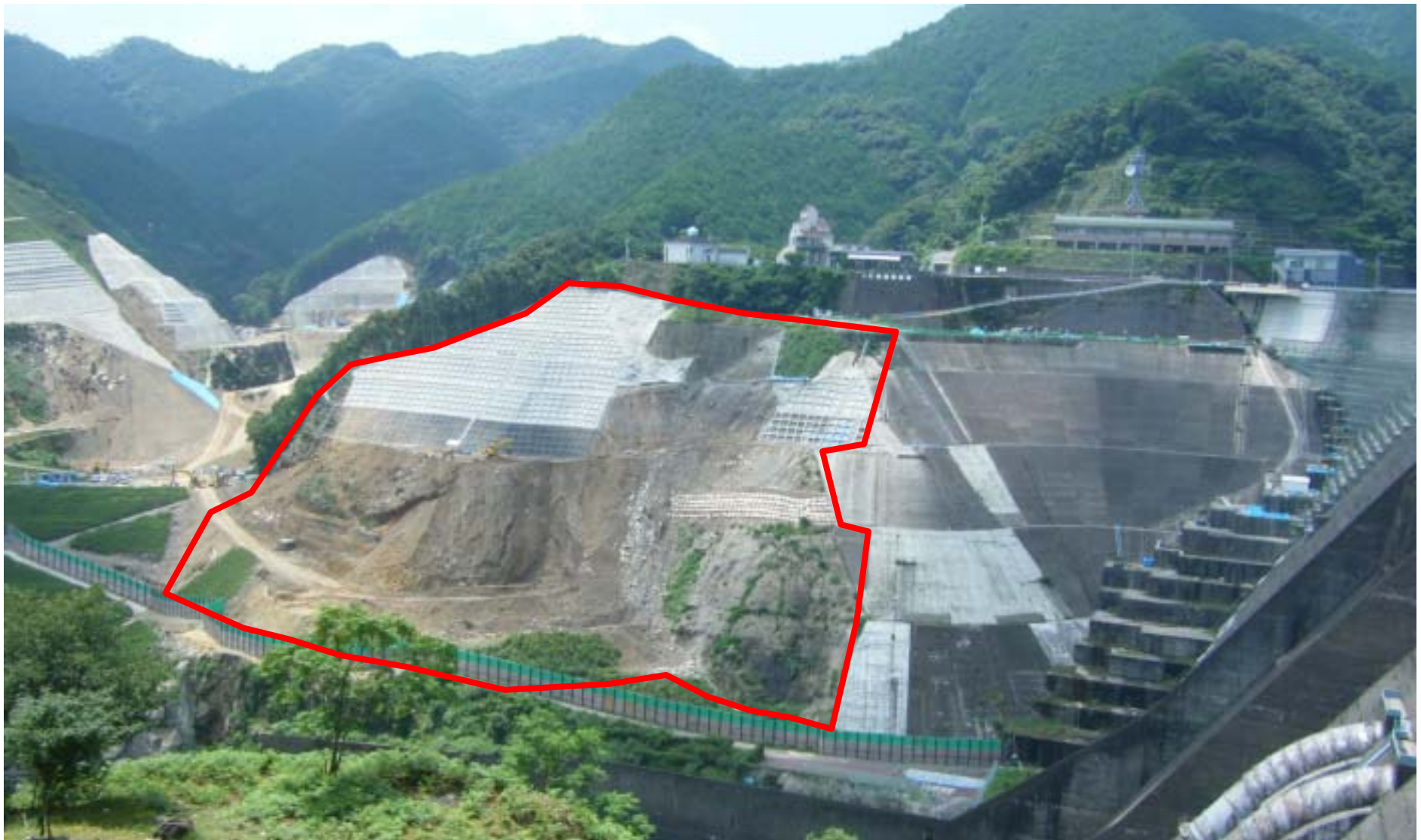
ダム下流の右岸側を望む
