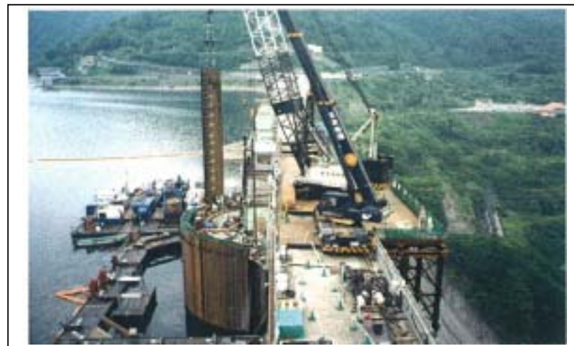
上流仮締切設置状況(他ダム事例)
