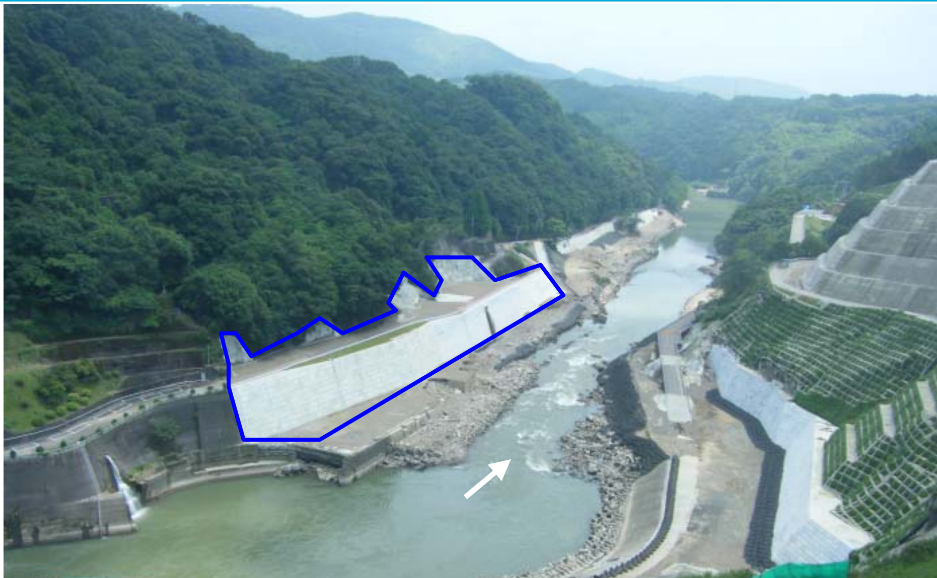
ダム側から下流側(左岸)を望む
