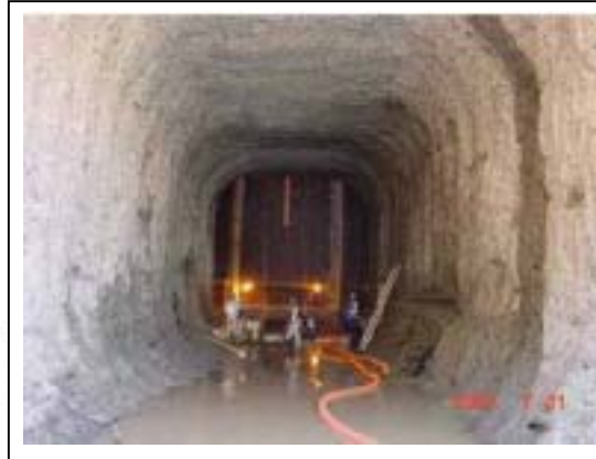
堤体貫通状況(他ダム事例)
