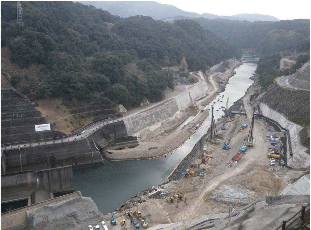
右岸より下流仮締切(右岸)、河道掘削(左岸)施工状況を望む
