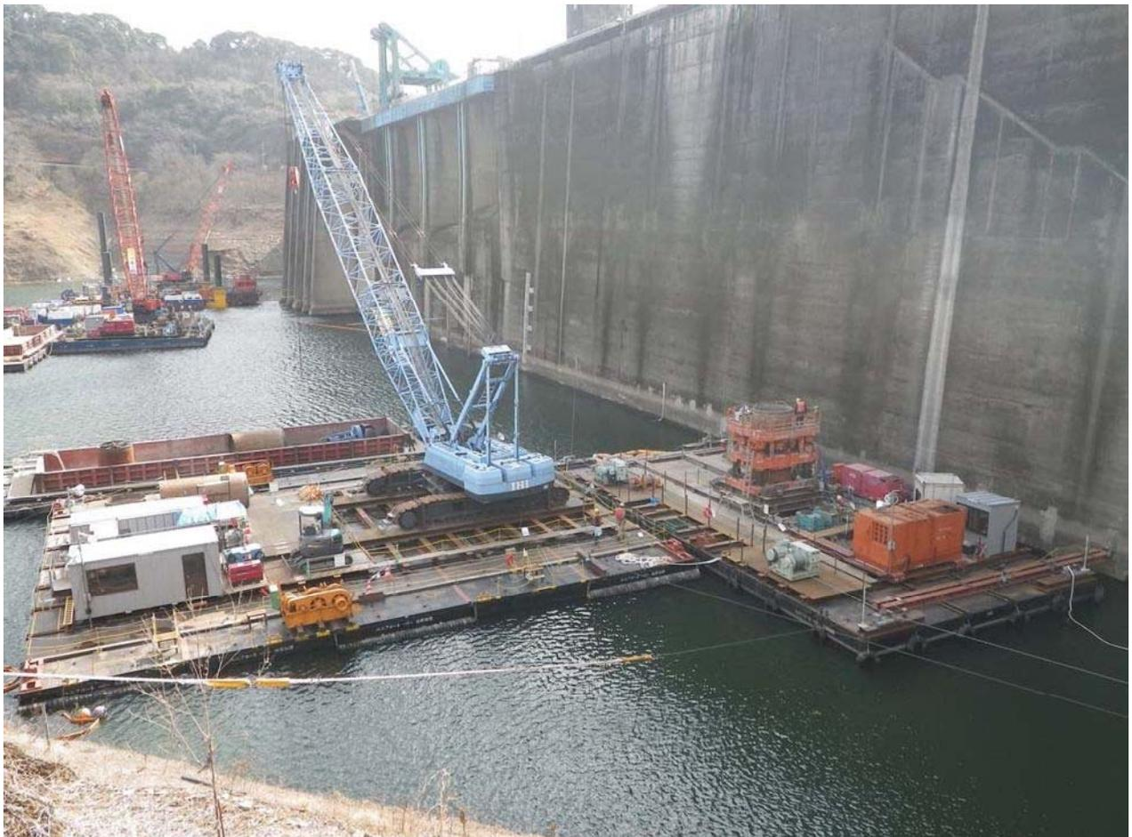
貯水池内 右岸既設フーチング撤去作業(全回転オールケーシング掘削) H24.1.11撮影
