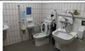
大芝生レストハウス 多目的トイレの様子
