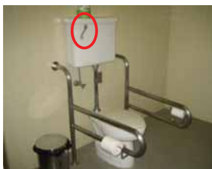
便器洗浄器具スイッチがレバーしかない（ボタン式が望ましい）
