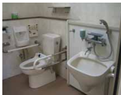
操作部が体の後方にくるため操作しにくい（前方に配置が望ましい）
