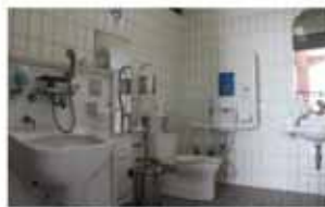
西口 (ゲート内) 多目的トイレの様子
