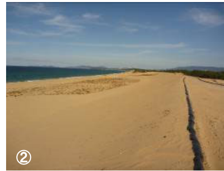
② 搬入土によりFH12、勾配1:3の土堤が造成されている
