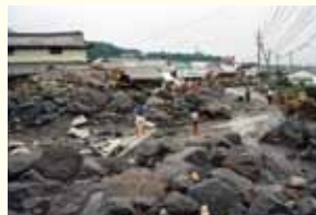
▲土石流被災状況 (H5.7.18)
