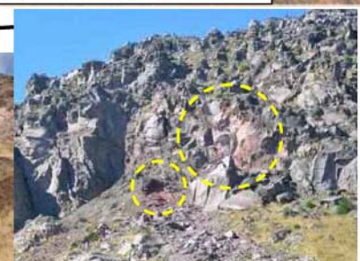
小崩落の状況
