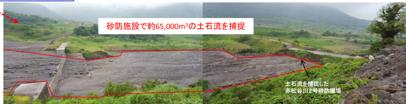
赤松谷川2号堰堤の堆砂状況
