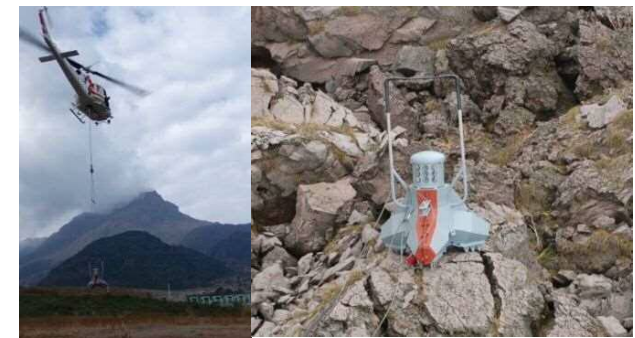
■ 図2 第11ロープ上部への設置状況(11/23)
