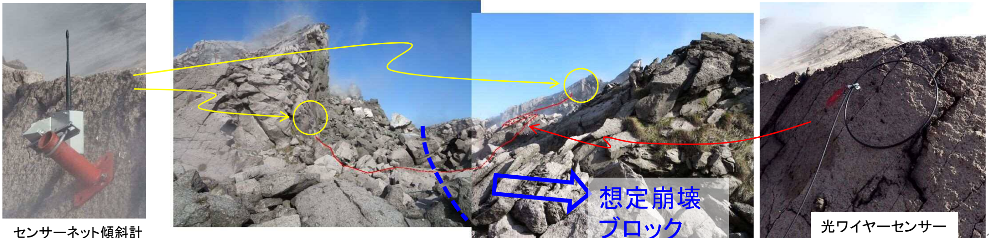
■センサーの現地設置状況
