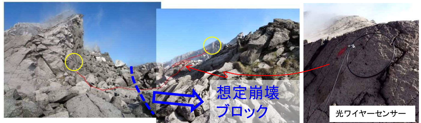
■ 図4 センサーの現地設置状況
