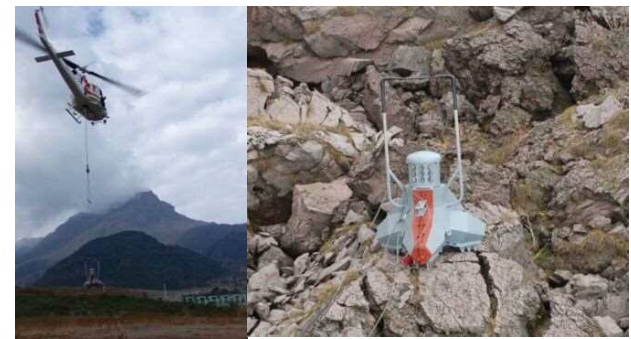
■ 図2 第11ローブ上部への設置状況(H28年11月23日)
