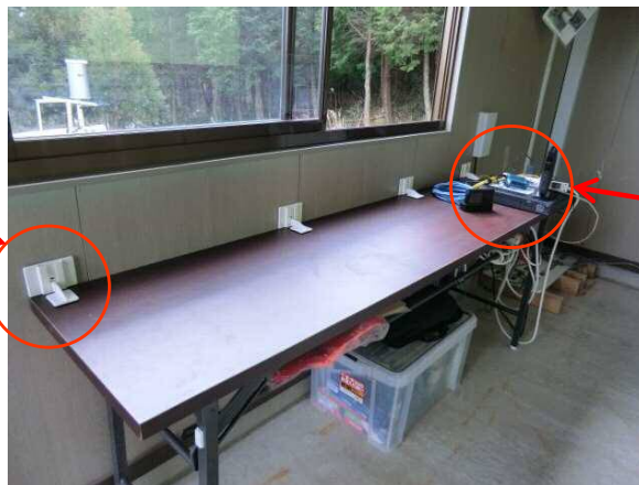
バンドでUPS、電源、ケーブル類を固定。
