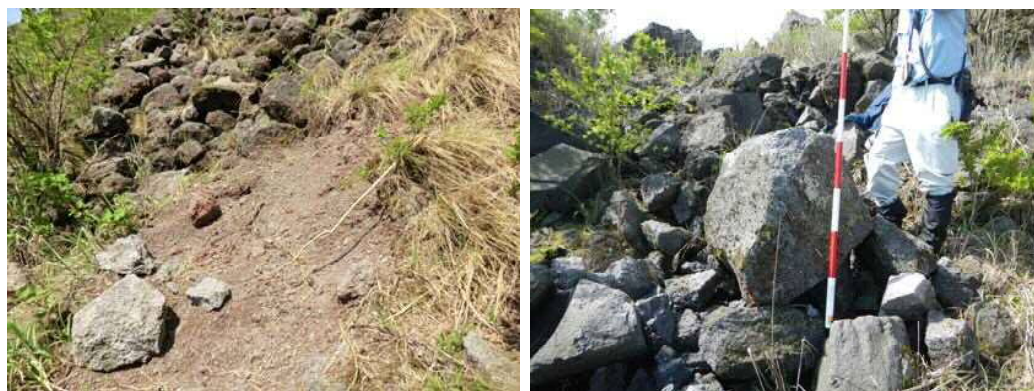
溶岩ドーム直下の東斜面(崩落堆積域)にて認められた落石
