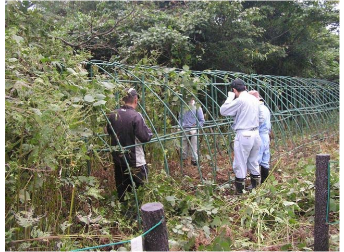
手入れ作業風景
