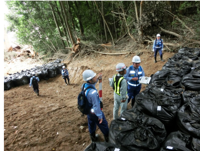
▲ 応急対策工の実施状況確認
