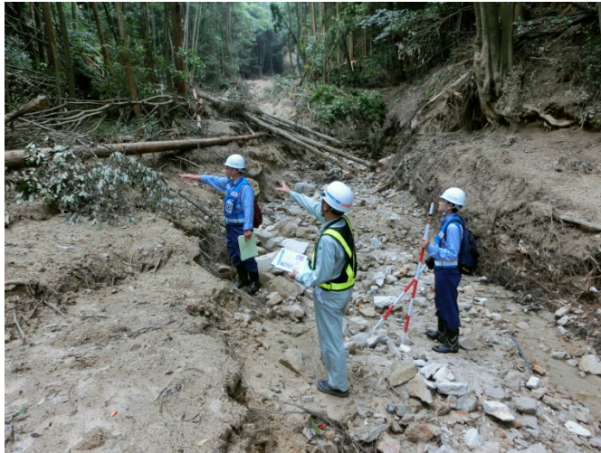
▲ 施工方法の確認
