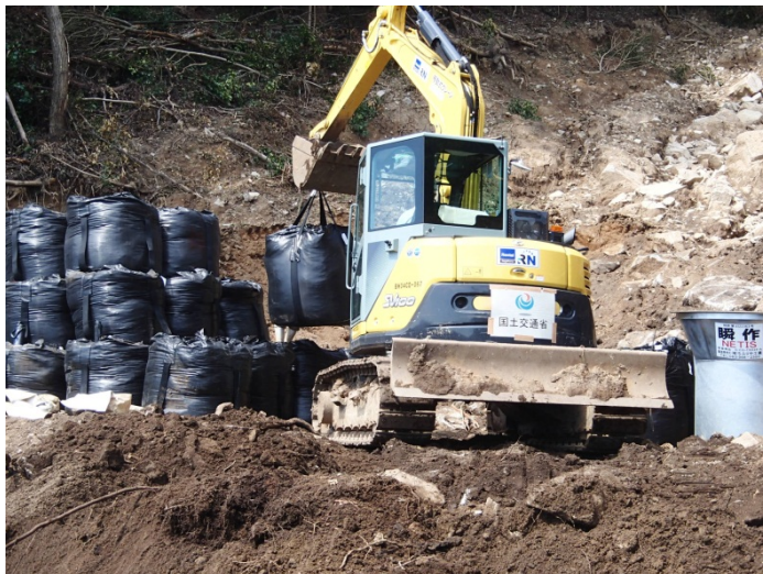
▲ 大型土のうの設置状況
