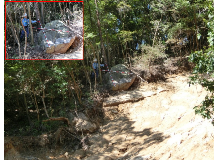
▲ 巨石の現地確認
