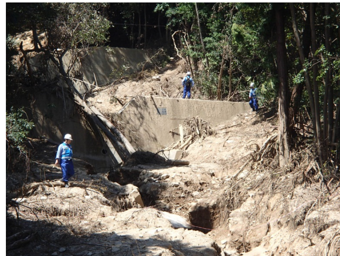
▲ 治山施設の現地調査
