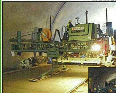
東九州自動車道 門川舗装工事
