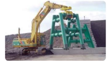
無人化施工による鋼製スリット砂防堰堤の工事
