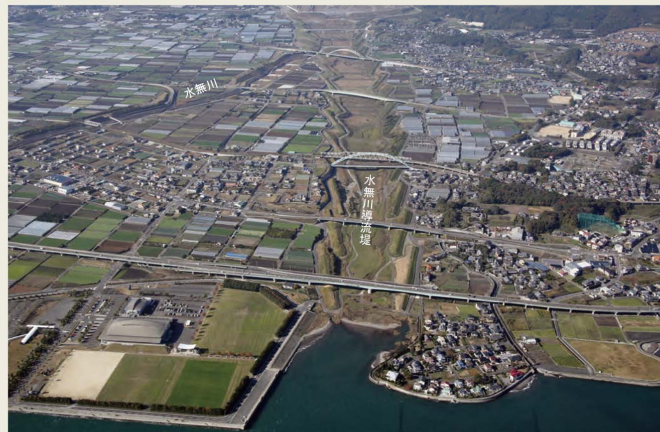
写真11：水無川導流堤（平成27年12月撮影）
