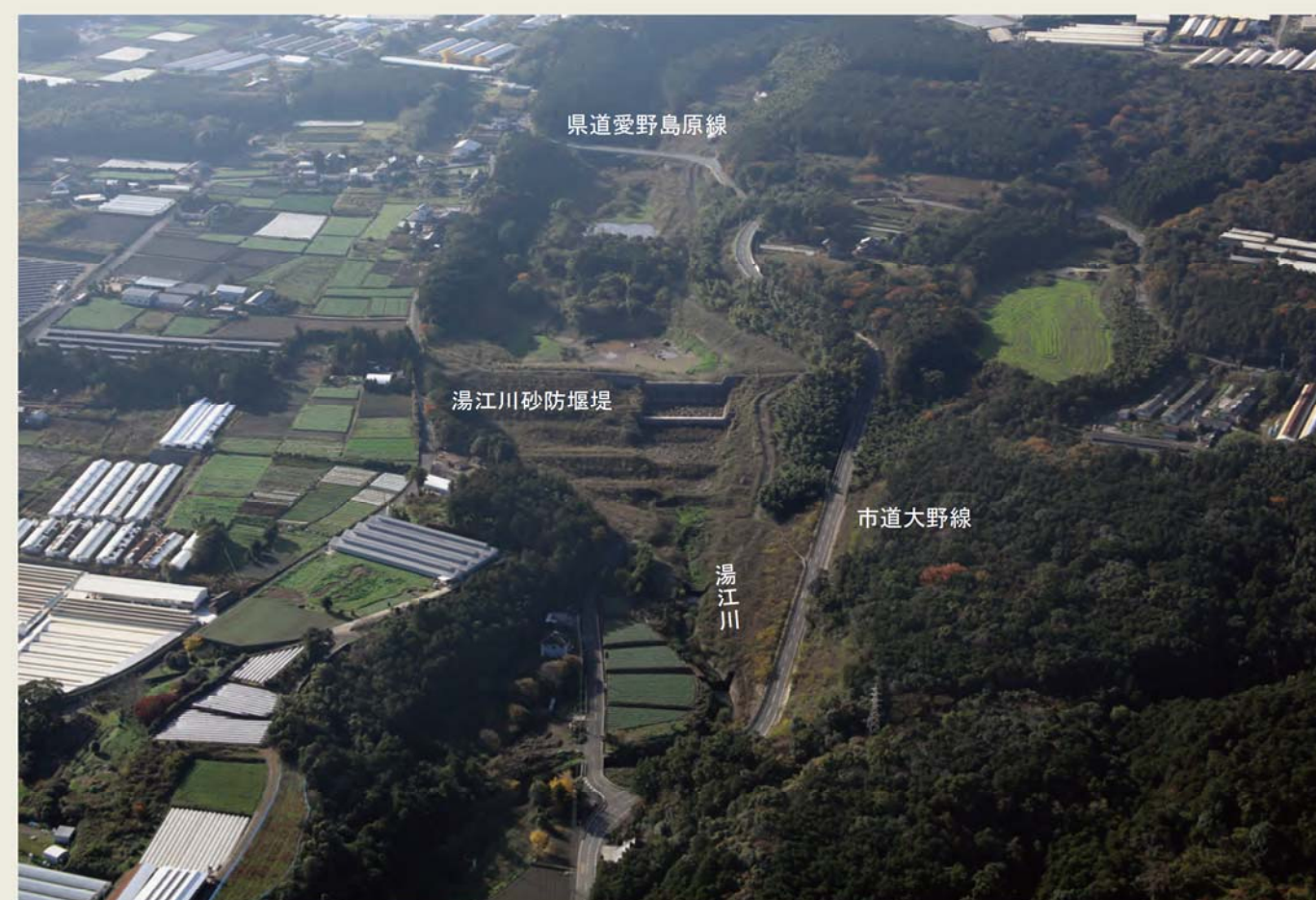
写真19：現在の湯江川砂防堰堤（平成27年12月撮影）
