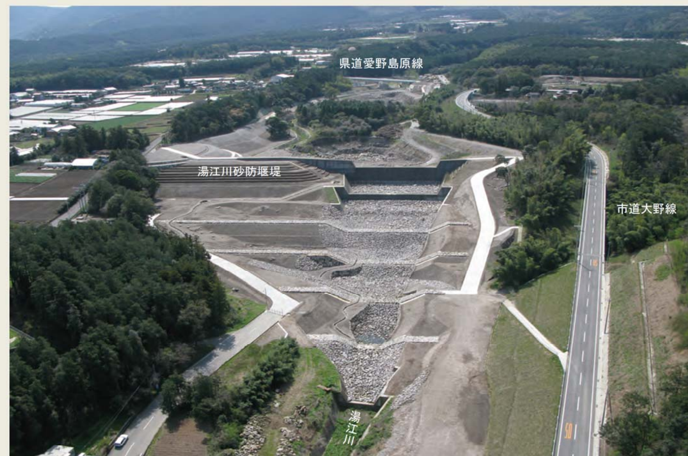
写真18：完成当初の湯江川砂防堰堤（平成22年3月撮影）
