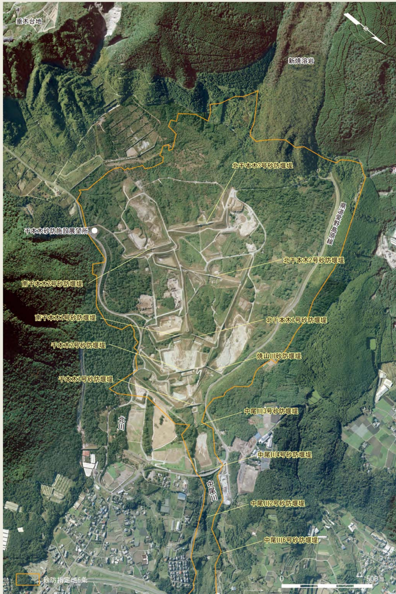
写真12：中尾川上流事業範囲（平成23年11月撮影）
