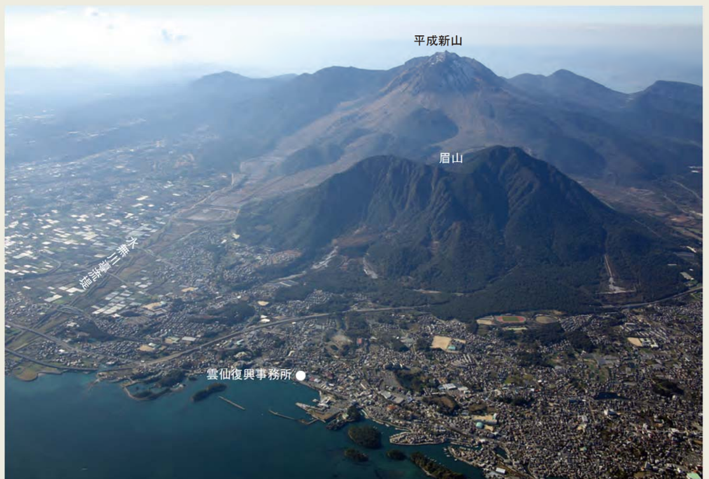
写真7: 眉山崩壊による流れ山 (平成27年12月撮影)
