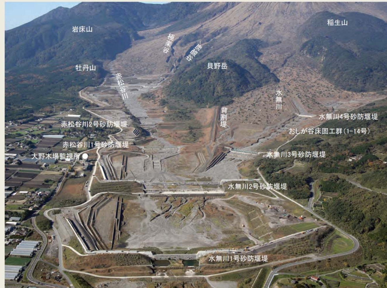
写真10：水無川砂防堰堤群（平成27年12月撮影）
