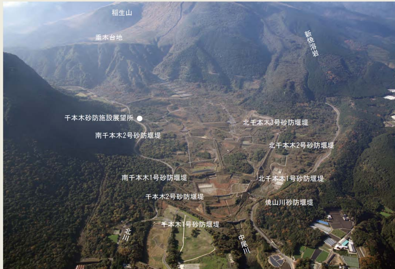
写真14：中尾川砂防堰堤群（平成27年12月撮影）
