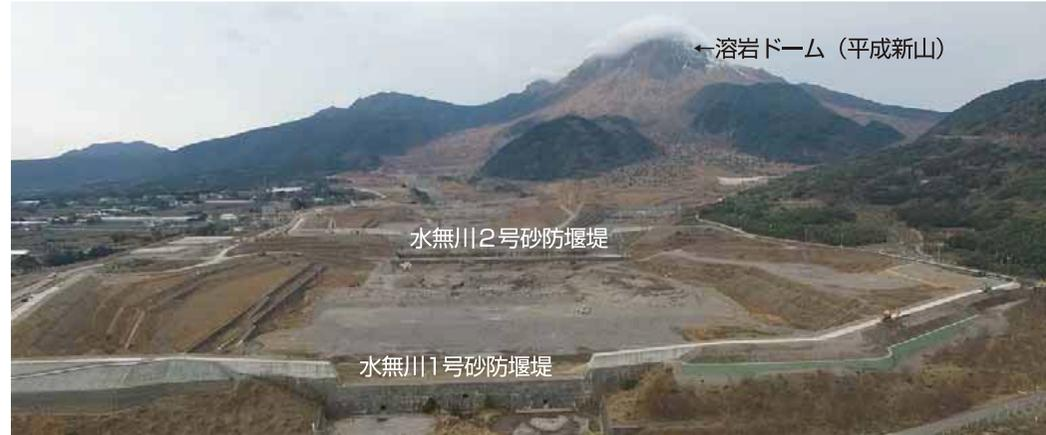
水無川1号・2号砂防堰堤高上げ工事箇所全景(平成30年2月2日撮影)
