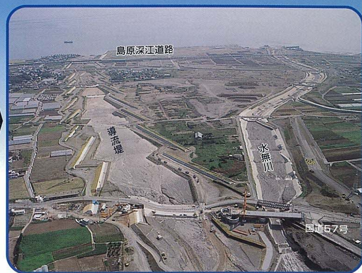
現在 (H9.9頃) の復旧状況
