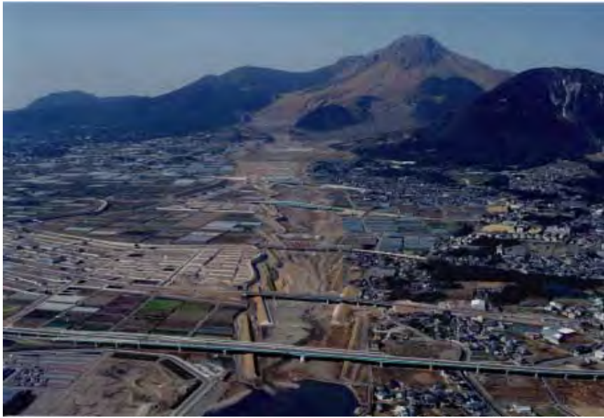
図-10 水無川導流堤（平成13年3月20日竣工） （撮影：平成13年2月11日）
