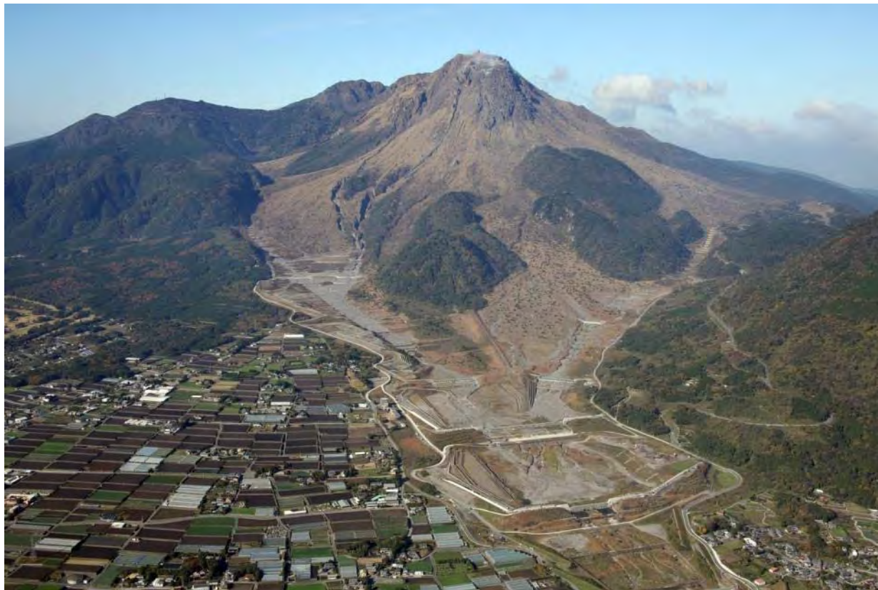
水無川流域の砂防施設（平成27年10月UAVによる撮影）
