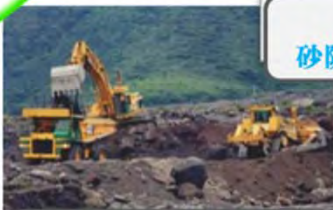
1994 土砂掘削に 無人化施工導入
