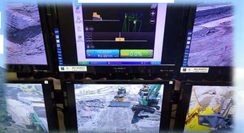
赤松谷川1号砂防堰堤
