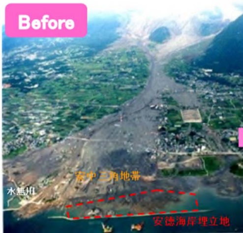
土石流による被害の状況(平成7年)
