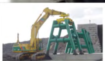
2001 スリット堰堤を 無人化施工
