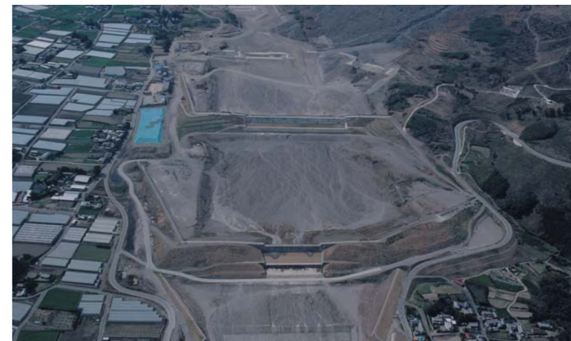
水無川1号砂防堰堤。高さ14.9m、長さ870mもあり、全国に約6万ある砂防堰堤の中でも日本一の長さです
