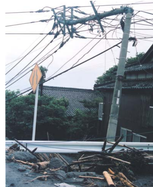
電柱がおれ、電気が一時止まったこともありました
