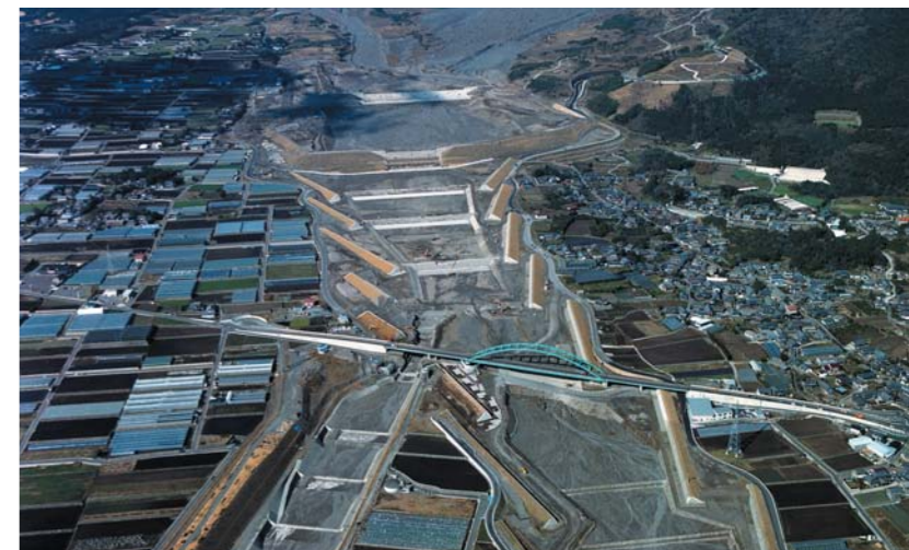
28～29ページの写真と合わせて見ると、導流堤で町が守られているのがよくわかるよ
