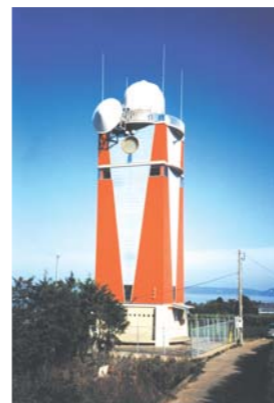
布津町にあるレーダー雨量計。レーダー雨量計は、降っている雨に電波を当てて、はね返ってくる電波の強さから雨の降り方を観測するもので、雨の強さ、雨域の広がり、その動きを連続的に知ることができ、降雨の予測などに利用できます
