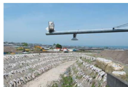
水位・流速計。川の水量の変化や流れの速さの変化で土石流発生を監視できることから、超音波を用いた水位計や電磁波を用いた流速計を設置しています。水位の急激な上昇は、川の流れに、土石が加わった可能性が高いことを示します
