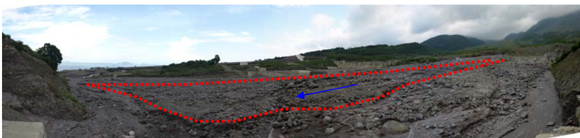
写真－2 赤松谷川床固工群周辺の土砂堆積状況
