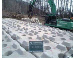
床固めブロックの無人化施工状況（三宅島）
