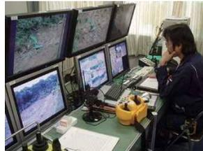
船石川土石流災害の復旧工事で活躍する無人化施工と操作室内状況
