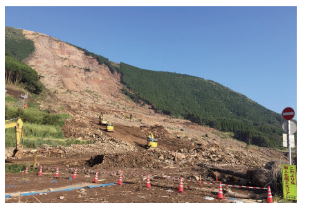
無人化施工(阿蘇大橋地区)
