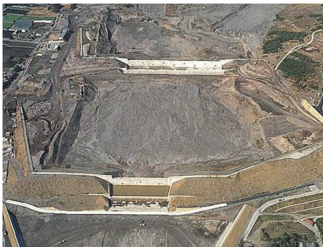
水無川1号砂防堰堤と工事(写真左)の様子
