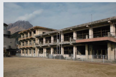
大野木場小学校被災校舎
