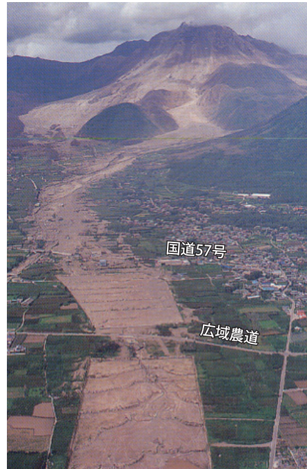
水無川に整備された1号遊砂地(下流側)・2号遊砂地(上流側):長崎県施工
