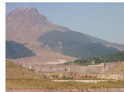
水無川1号砂防堰堤
