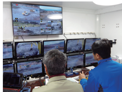
地元企業による無人化施工除石の試験施工の様子
