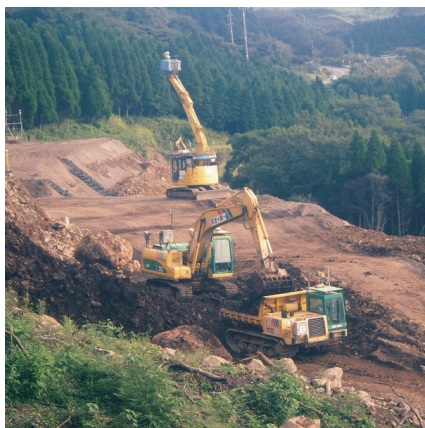
無人化施工(阿蘇大橋地区)
