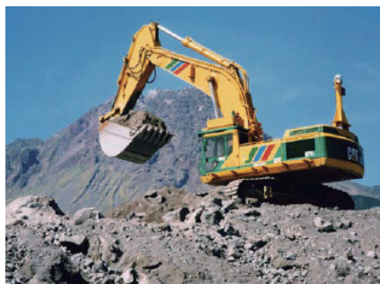
無人化施工による除石工事
