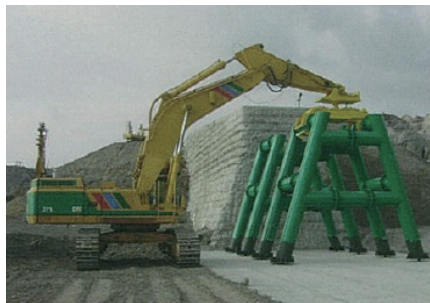
無人化施工による鋼製スリットの据付工事
