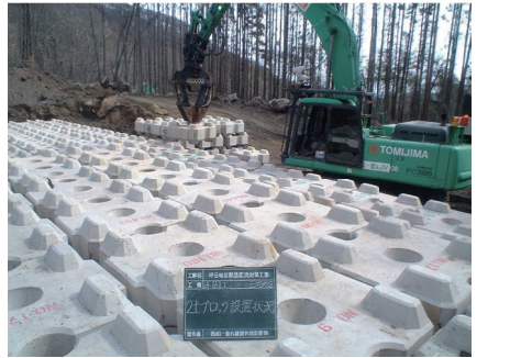
床固めブロックの無人化施工状況(三宅島)
