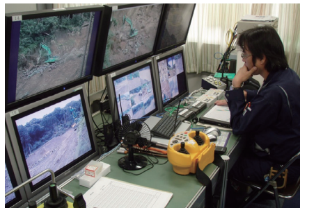
船石川土石流災害の復旧工事で活躍する 無人化施工と操作室内状況
