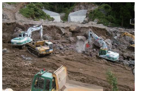
床固めブロックの無人化施工状況(三宅島)
