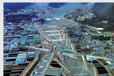
水無川導流堤
