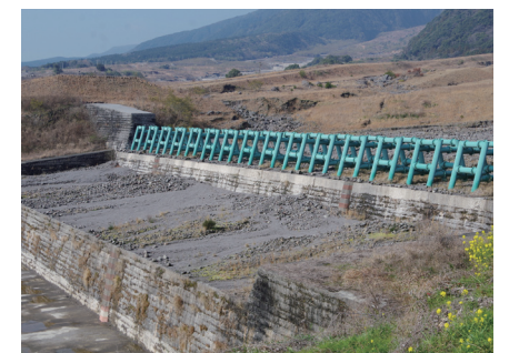
水無川3号砂防堰堤
