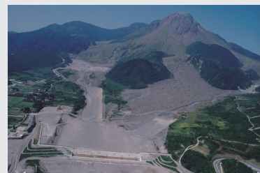
水無川2号砂防堰堤
