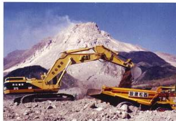
口絵23 無人化施工による警戒区域内での除石 （1994（平成6）年4月11日）（松井宗廣撮影）
