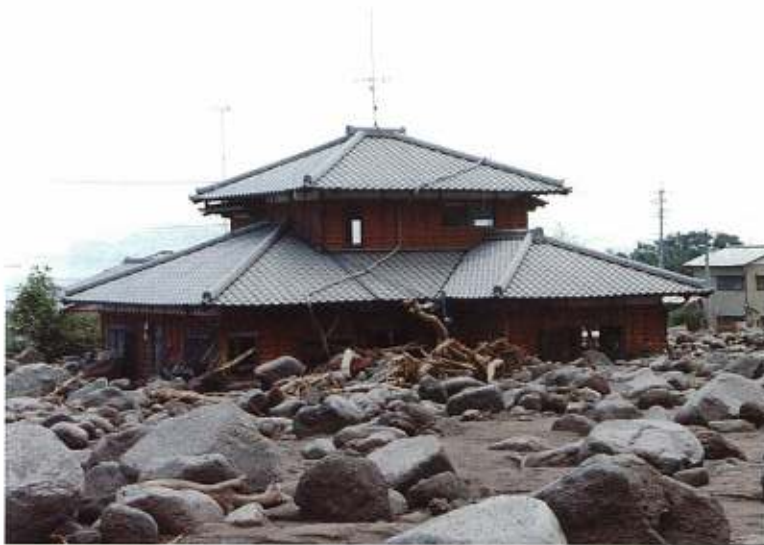
口絵10 土石流に埋まった家屋(安中地区)(1993(平成5)年4月30日)(杉本伸一撮影)
