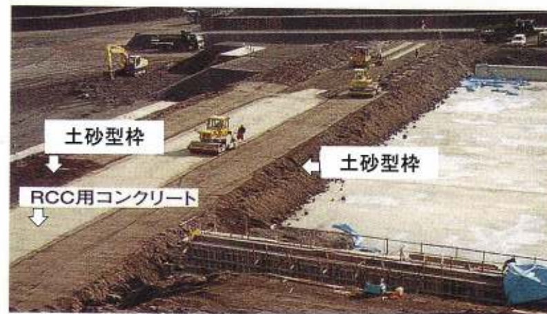
写真-2 土砂型枠を用いた本体部の建設 （出典：雲仙復興工事事務所事業概要）
