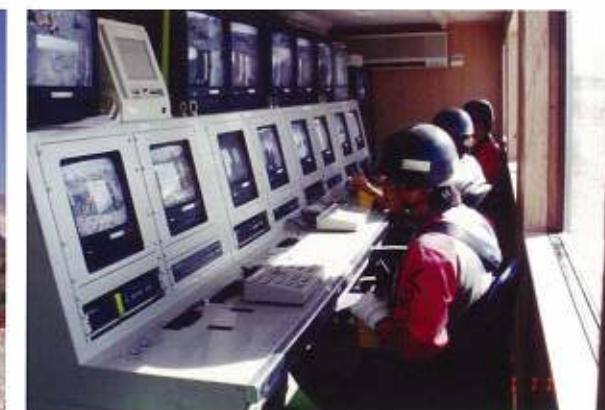
口絵24 無人化施工の遠隔操作作業状況 （1994（平成6）年4月11日）（松井宗廣撮影）
