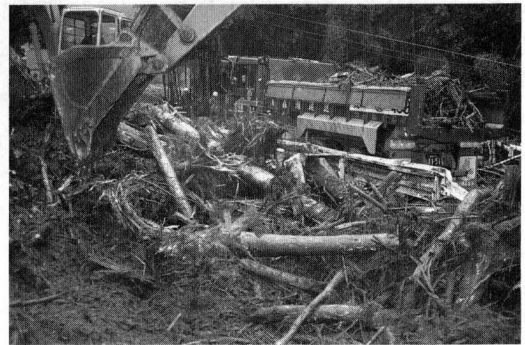
写真-8 流木による橋梁の閉塞と土石流の氾濫 (6月30日, 湯江川)
