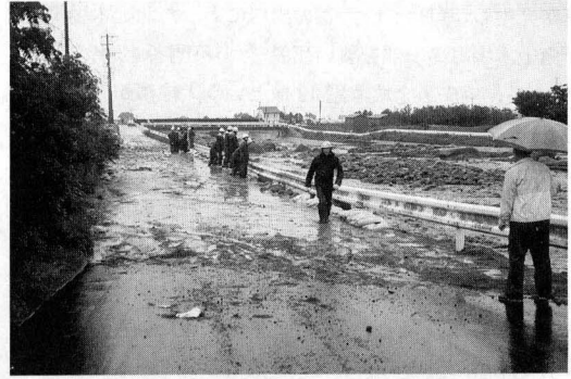
写真-2 5月15日に水無川で発生した土石流による河道 への土砂堆積状況 (長崎県砂防室提供)
