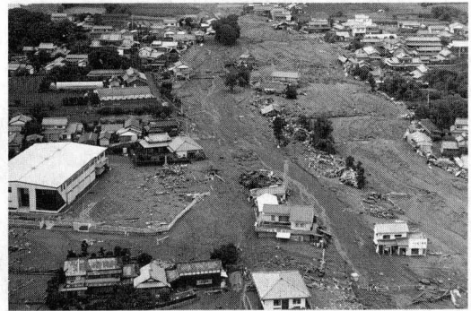
写真-6 6月30日に水無川で発生した土石流の 氾濫堆積状況
